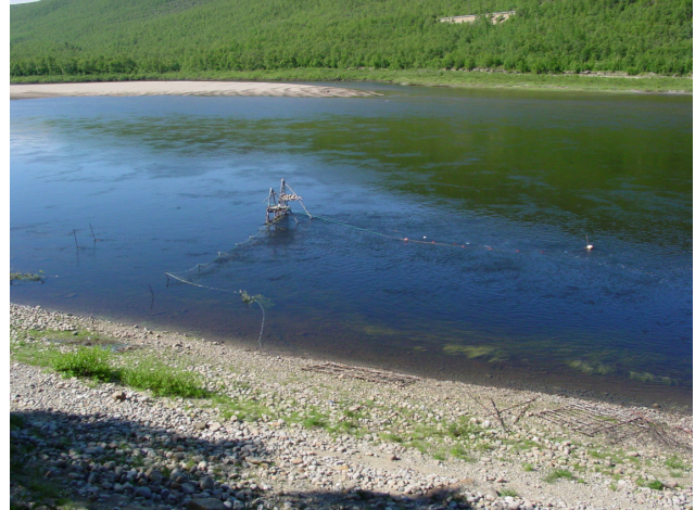
Foto 4a og 4b. Mange av strandstengslene settes sammen av enkle trebukker i Tanavassdraget (foto Eero Niemelä).
